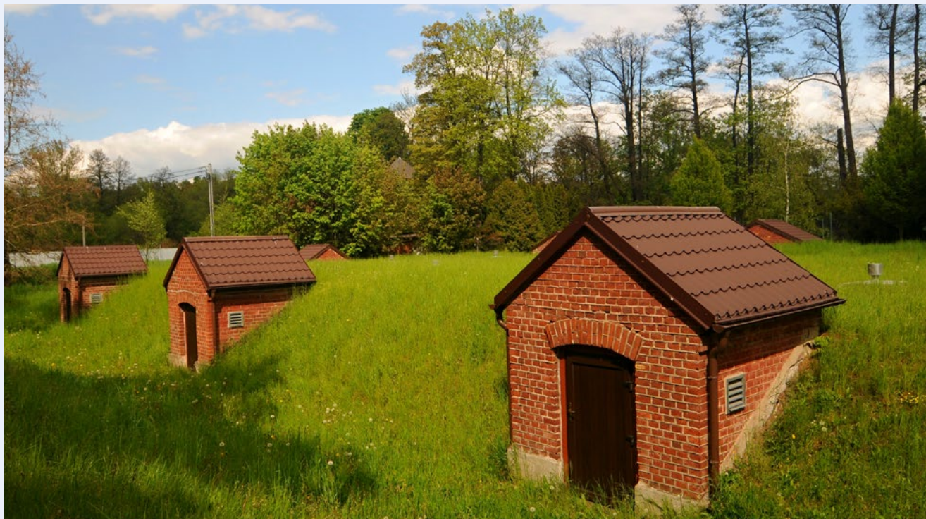
Historické vodojemy ve vodárenském areálu v Opavě na Jaselské v blízkosti nejstaršího vodního zdroje ve městě Opava – Jaktař. Ten částečně zásobuje okrajové lokality města, když je doplňován pitnou vodou z Ostravského oblastního vodovodu (Úpravný vody Podhradí).
