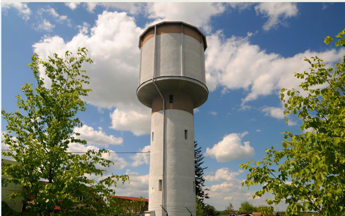
Věžový vodojem v obci Uhlířov na Opavsku s kapacitou 500 metrů krychlových pitné vody.
