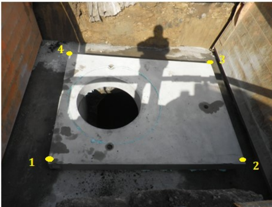
Bod č. 1,2,3,4 Roh vnějšího podzemní obvod šachty
