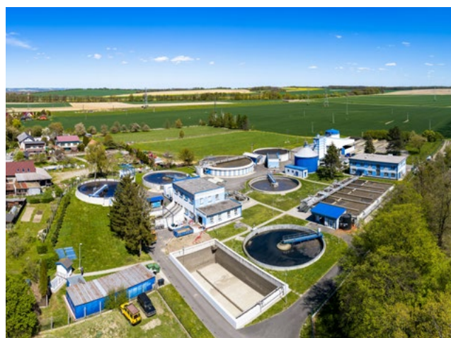
Čistírna odpadních vod v Šenově u Nového Jičína.
